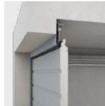
Montage hinter der Öffnung - Blendrahmen hinter der Öffnung
