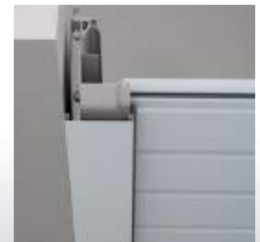
Montage in der Öffnung - Blendrahmen in der Öffnung
