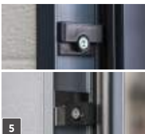
5 System zur Verhinderung des Herunterfallens des Flügels.
