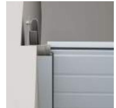
Montage hinter der Öffnung - Blendrahmen hinter der Öffnung
